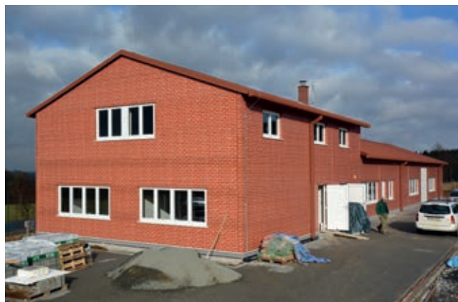
V popředí haly je dvoupodlažní administrativní budova.
