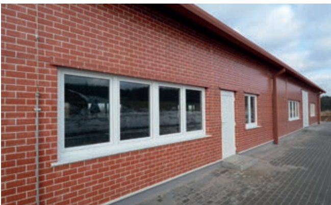
Montovaná hala je opláštěná sendvičovým panelem.
