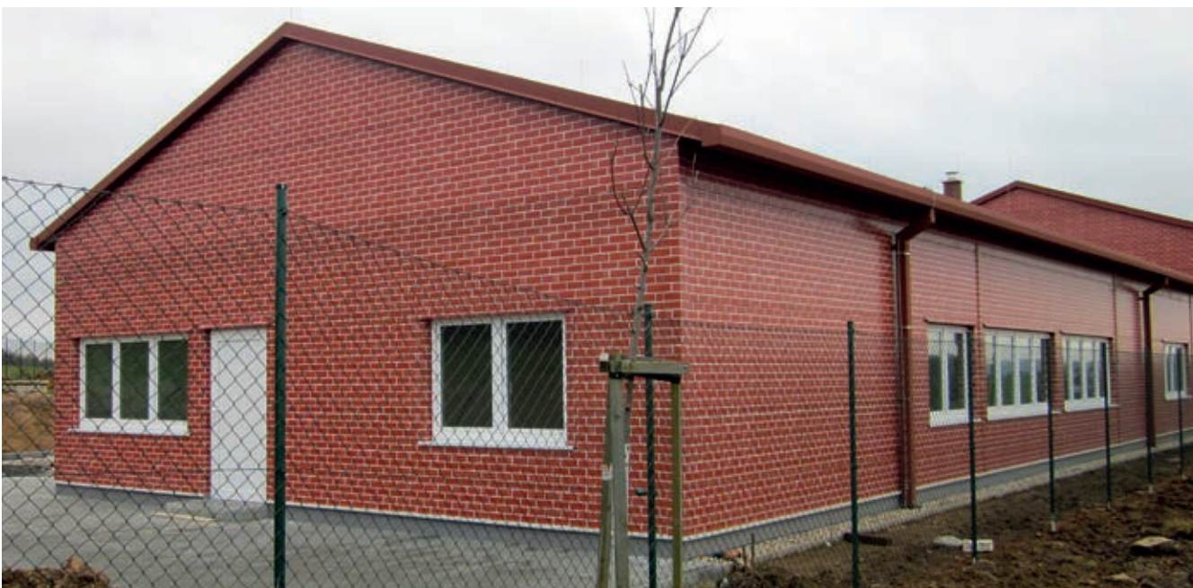
Opláštění ocelové haly panelem imitace cihla je ojedinělé.
